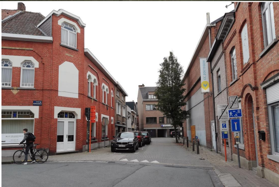
Foto 5: zicht op CC met laad -en loskade (rechterkant)
